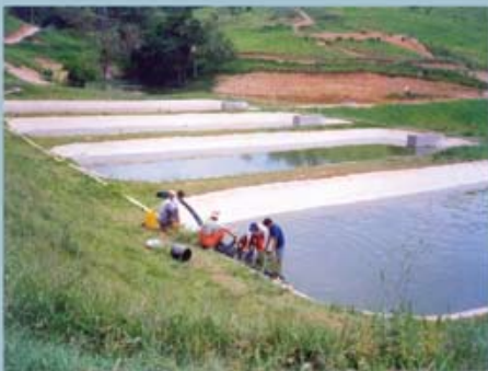
Vinimanta para revestimento de reservatório de água.
